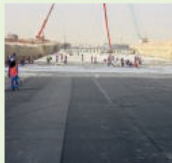
Аэропорт Джебел Али, ОАЭ, гидроизоляция подвальной части
