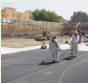
Национальный арабский банк в Джедде, Саудовская Аравия, гидроизоляция подвальной части
