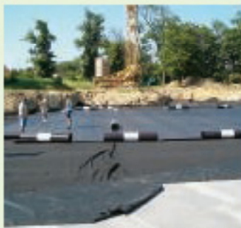
Отель Сарвар, Венгрия, гидроизоляция подвальной части
